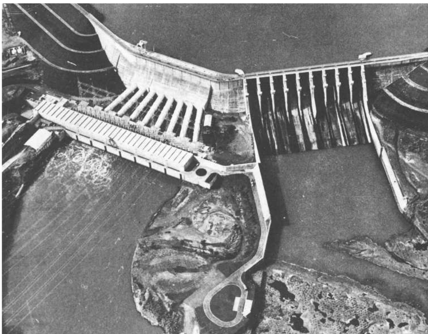
Usina hidrelétrica de Marimbondo — Furnas, com oito geradores de 180 MVA.
